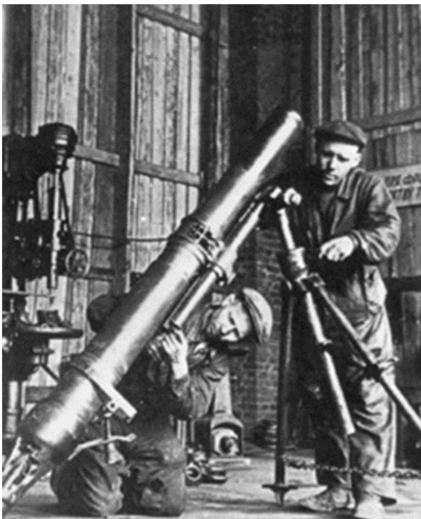
Рисунок 11 – Сборка миномётов на Уралхиммашзаводе
