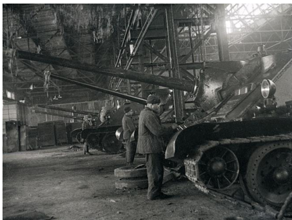
Рисунок 9 – Рабочие Уральского завода тяжелого машиностроения за сборкой самоходно-артиллерийских установок СУ-85, 1943 год
