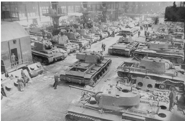
Рисунок 10 – Сборочный цех танков KV-1 Кировского завода
